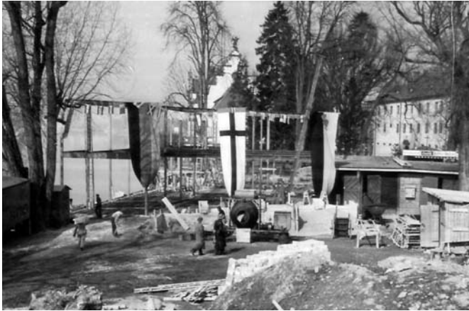
Richtfest für das neue Bootshaus
